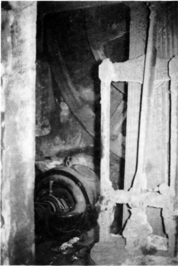
Foto 3. Motor eléctrico junto a la máquina de vapor de la fábrica de Juan Turu. Debido a las frecuentes restricciones eléctricas que hubieron hasta finales de los 50, se utilizaba una u otro.
