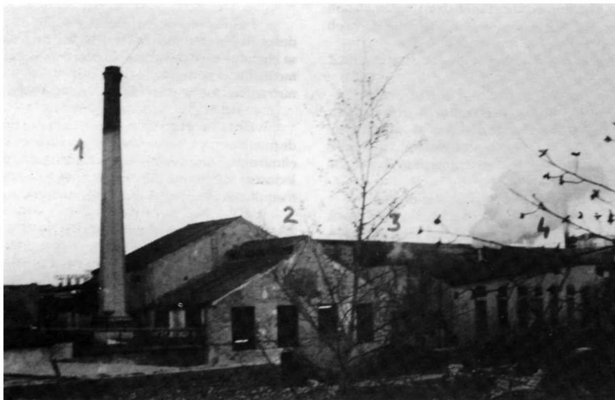
Foto 9. Fábrica de Juan Turu. 1) chimenea de la caldera de vapor, 2) zona de autoclaves, 3) zona de extractores, 4) secadero de brisas (nube de vapor de agua del secadero).
