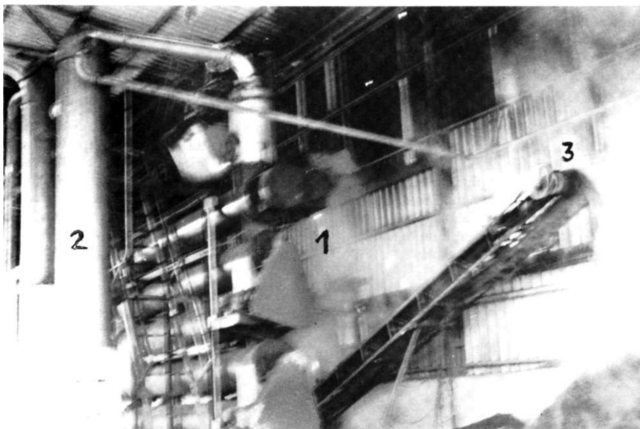
Foto 11. Maquinaria moderna de obtención de flemas. 1) destilador de alcohol, 2) condensador de flemas, 3) cinta transportadora de brisas desalcoholizadas.
