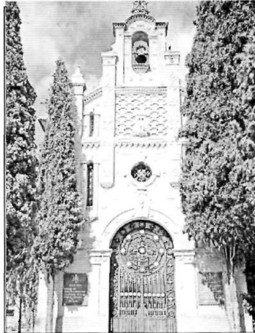
Fig. 12 - Fachada de la capilla.
