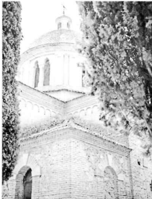
Fig. 11 - Vista exterior de la capilla del cementerio.
