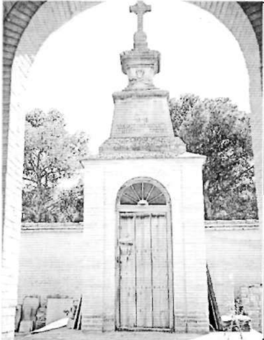
Fig. 10 - Construcción sobre el osario.
